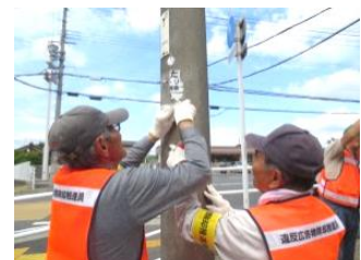
除却作業風景2
