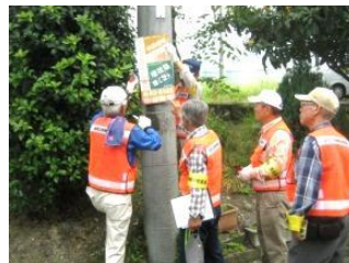
除却作業風景1
