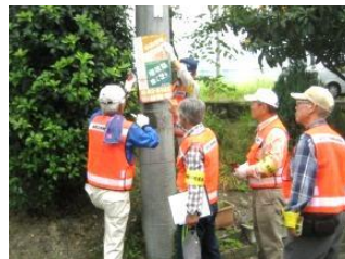
除却作業風景1
