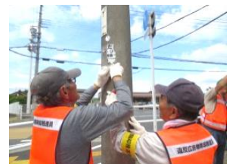
除却作業風景2
