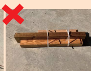
木製品を解体したもの
