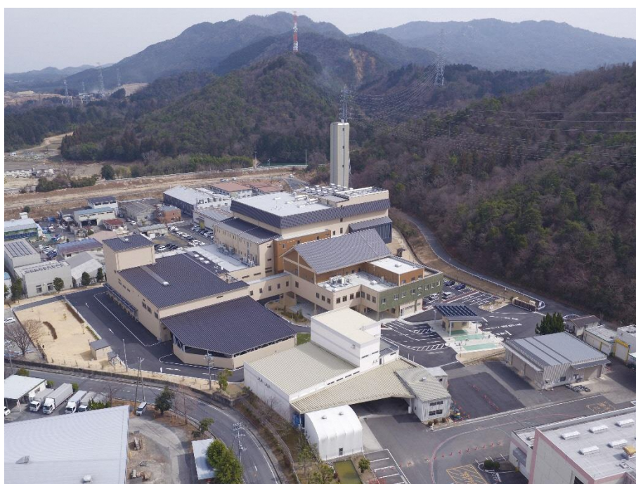
草津市立クリーンセンター
