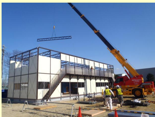
仮設事務所設置 写真
