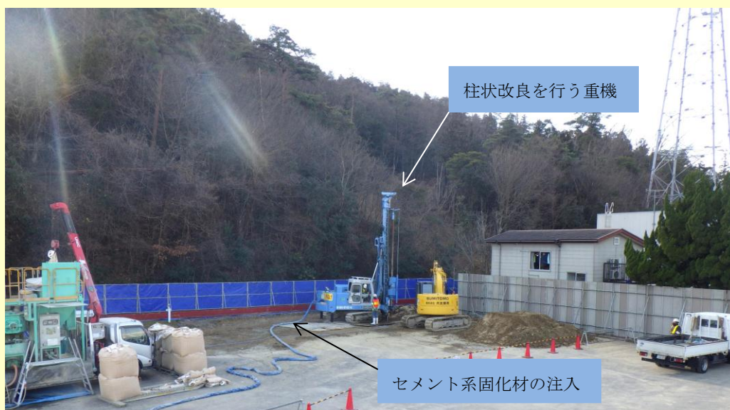
柱状改良工事 写真
