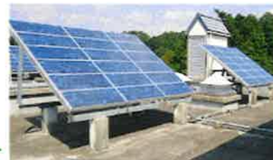
▶ 太陽光発電パネル設置
