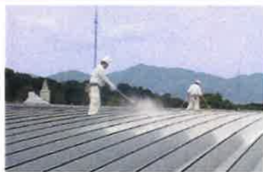
◀ 工場棟 屋根遮熱塗料の塗装
