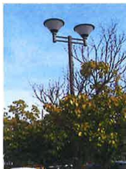
▲LED照明への更新
