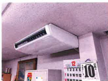
▲ 空調機器の更新
