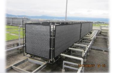
<遮熱ネットの設置>
