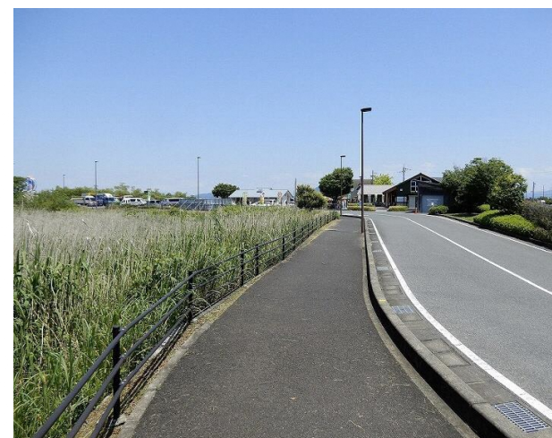
▲歩道（幅員は約 3 m） (夕映え通りから道の駅方向をみる)
