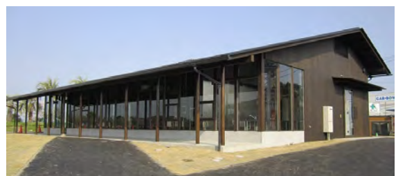
▲「道の駅みのりの郷東金」農産物加工場増築 出典：東金市ホームページ
