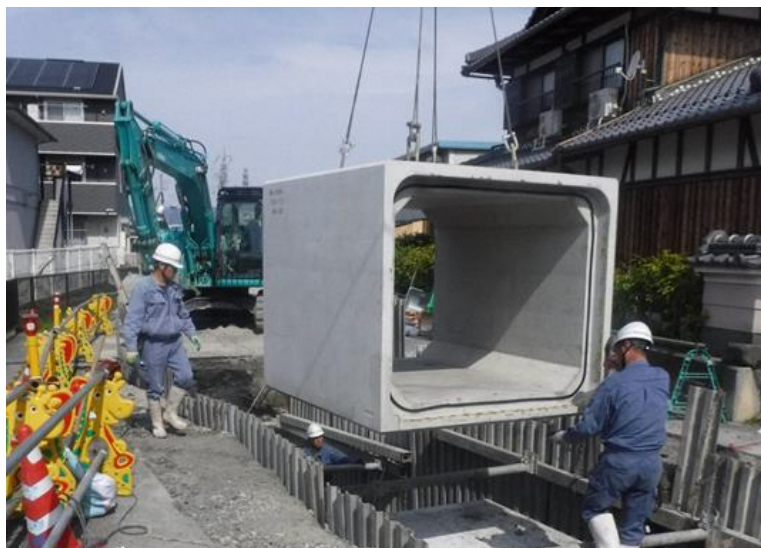
図表 3-8 雨水幹線整備の状況
