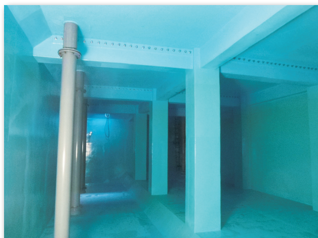
ロクハ浄水場旧館浄水池（耐震補強完了後）
