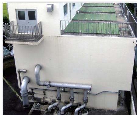
高度浄水処理施設
