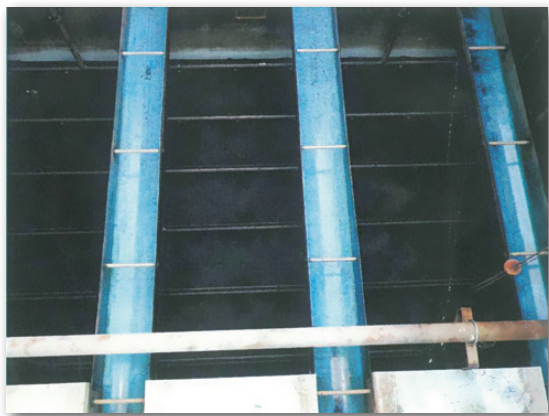
活性炭吸着地内部
