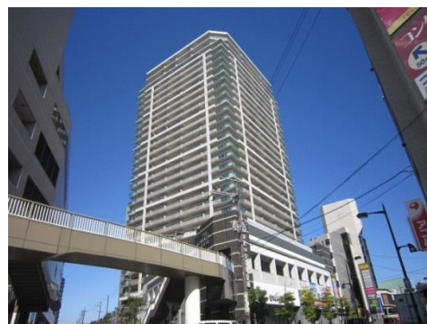
●図 10-11 草津タワーの写真
