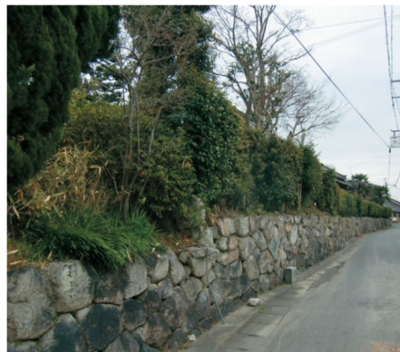
低めの石垣が設置された空間。
