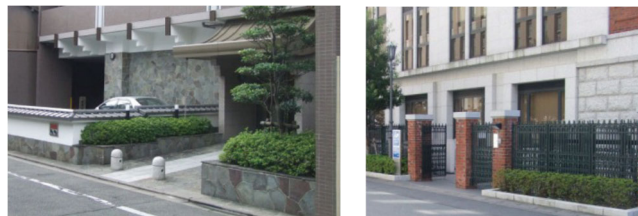
随所に石材等を用いた建築物。
