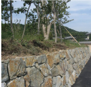
自然素材を用いた擁壁。
