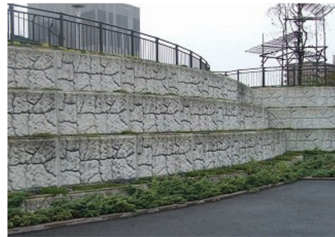
コンクリートを用いて石材を模した擁壁。
