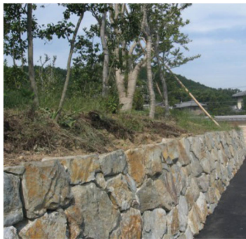
自然素材を用いた擁壁。
