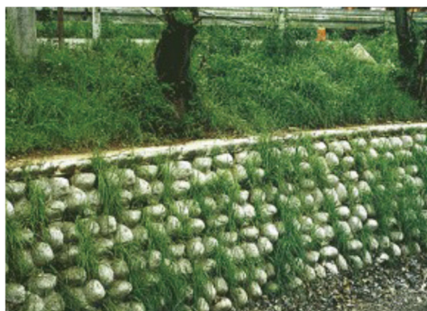
石材を用い、生物の生息環境に配慮された護岸。
