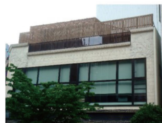
屋上工作物の目隠し措置。
