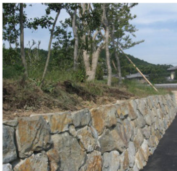
自然素材を用いた擁壁。
