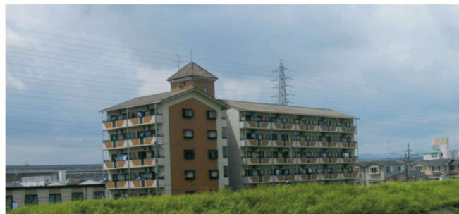
住棟の向きに変化をもたせることで単調な景観になることを防ぐとともに、勾配屋根を設ける等、建築物全体の意匠にまとまりをもたせた集合住宅。
