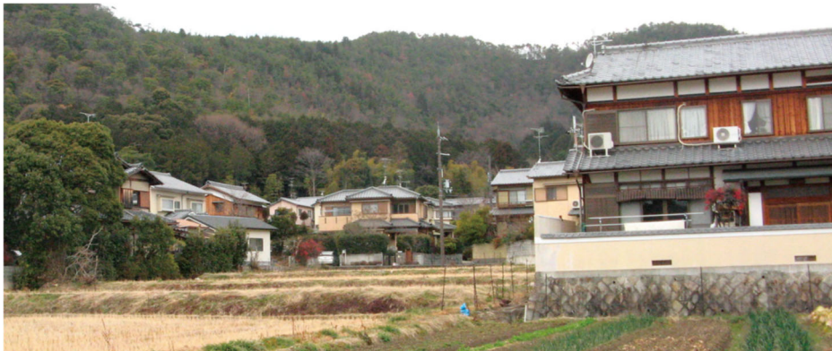
日本瓦に木板等伝統的な素材が用いられている建築物。
