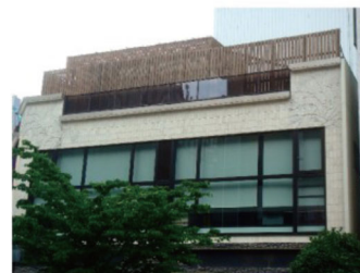
屋上工作物の目隠し措置。
