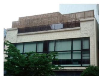
屋上工作物の目隠し措置。
