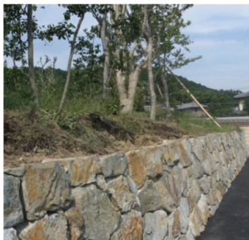
自然素材を用いた擁壁。
