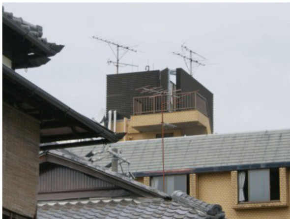
屋上工作物に落ち着いた色彩の「目隠し」を設けている例。
