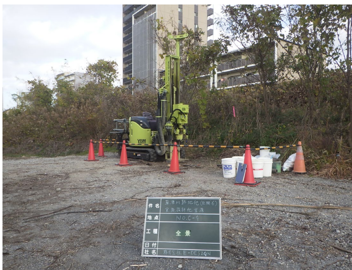
図2.2.1 室内コーン試験用試料採取状況(機械掘削：地点No. C-4)(再掲)
