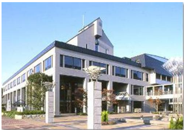
市庁舎：平成 4 年 5 月竣工
