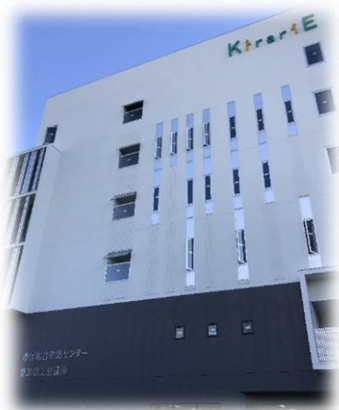
キラリエ草津外観(建物西側)
