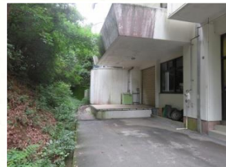
②屋外 プラットホーム
