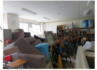
③3階 既存配膳室内部
