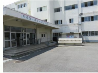
①屋外 プラットホーム周囲
