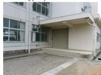
②屋外 プラットホーム
