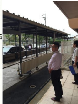
①屋外 旧配膳室前車付け
