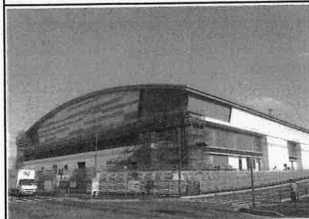
インフロニア草津アクアティクスセンター (草津市立プール) ※令和6年2月現在の様子
