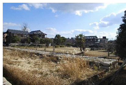
図 4-24 矢橋港の石積突堤
