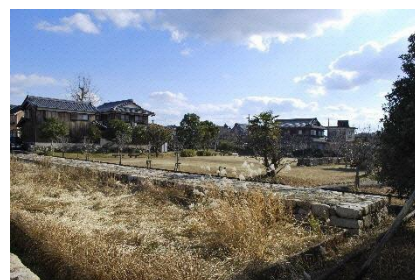
図 4-25 矢橋港の石積突堤
