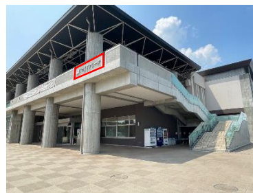
コンクリート壁面④
