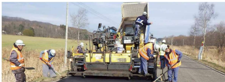
アスファルト舗装工事の状況
