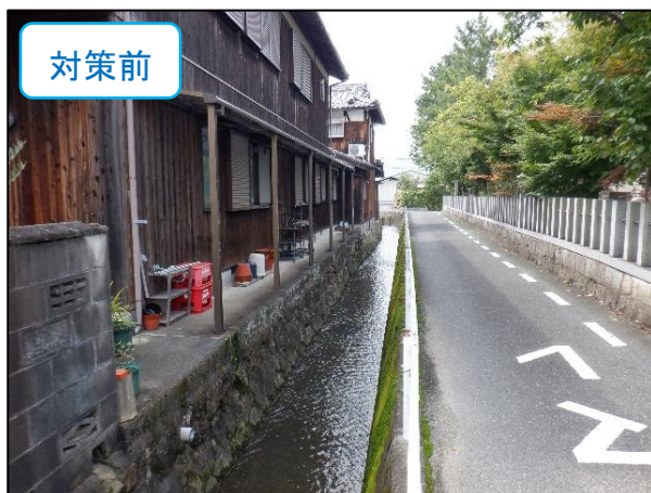
市道 南山田学校線での対策事例
