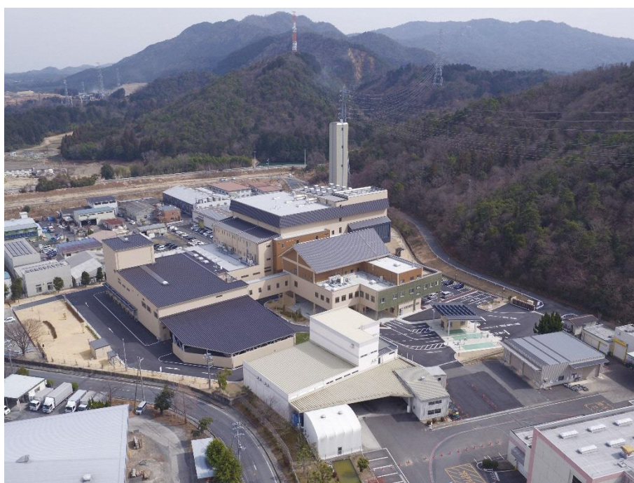
草津市立クリーンセンター
