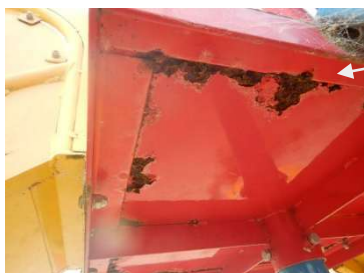
複合遊具 踊場裏面腐食
