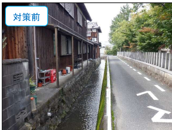
市道 南山田学校線での対策事例
