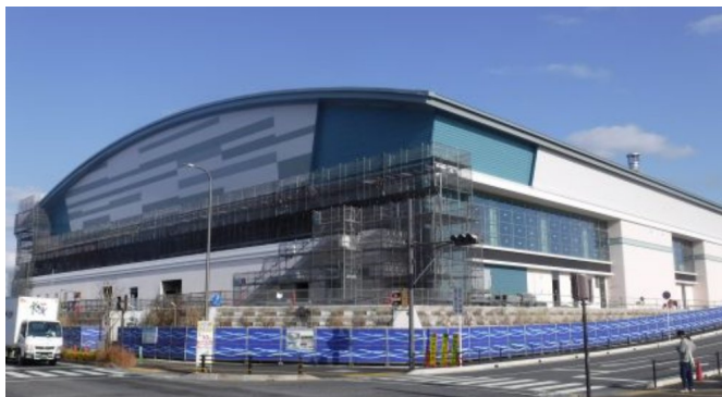
【草津市立プール(2月現在の状況)】
