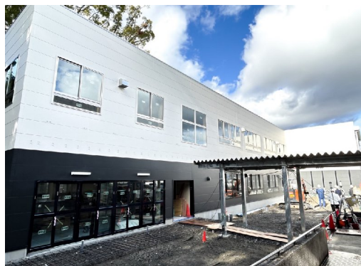
【志津小学校仮設校舎(2月現在の状況)】
