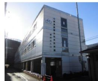
草津駅東自転車駐車場
