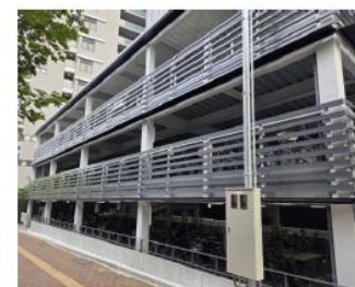
南草津駅西口第2自転車駐車場
