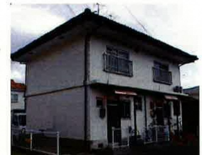
木川団地(簡易耐火)
