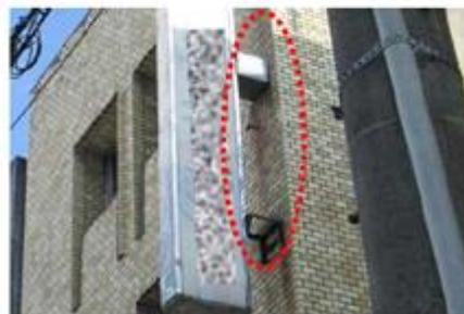
外壁との取付部の腐食
