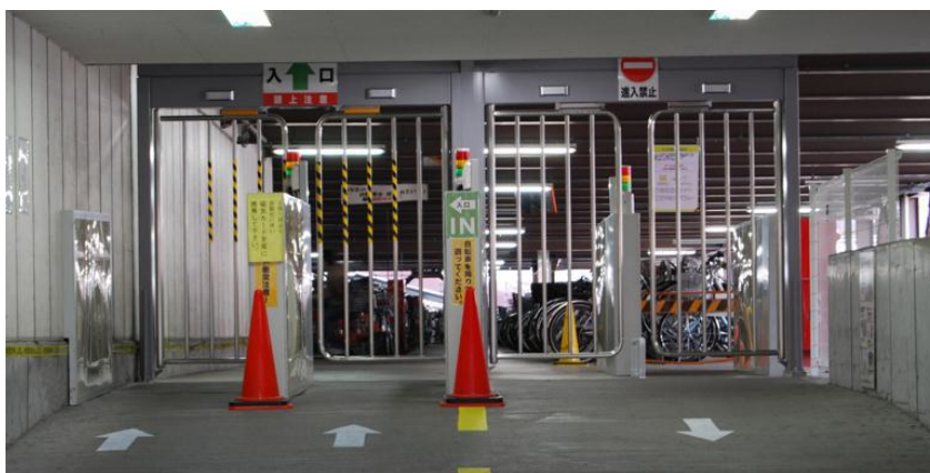
図 5.2 市営南草津駅自転車自動車駐車場のノンストップ自動ゲート
