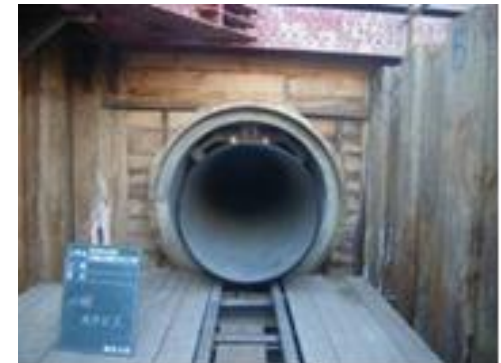
■ 農業用水路の更新 (パイプinパイプ工法)
