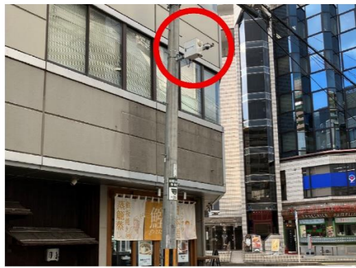
▲⑰市道宮町渋川線他管理用カメラ整備事業
