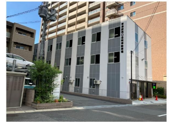
▲⑤草津駅西口自転車駐車場整備事業 （地域生活基盤施設）
