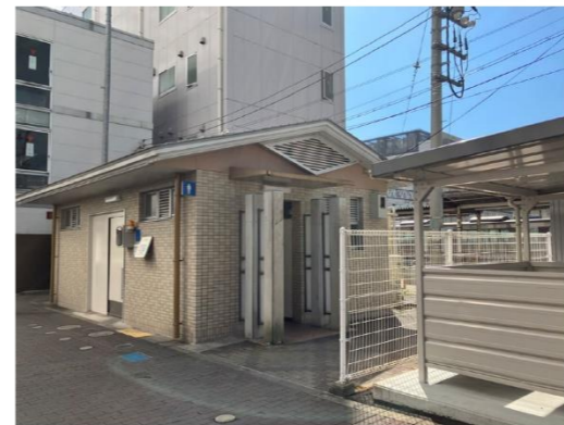
▲⑧草津駅東口公衆便所更新事業 （高質空間形成施設）
