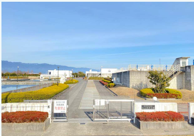
北山田浄水場
