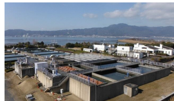
北山田浄水場
