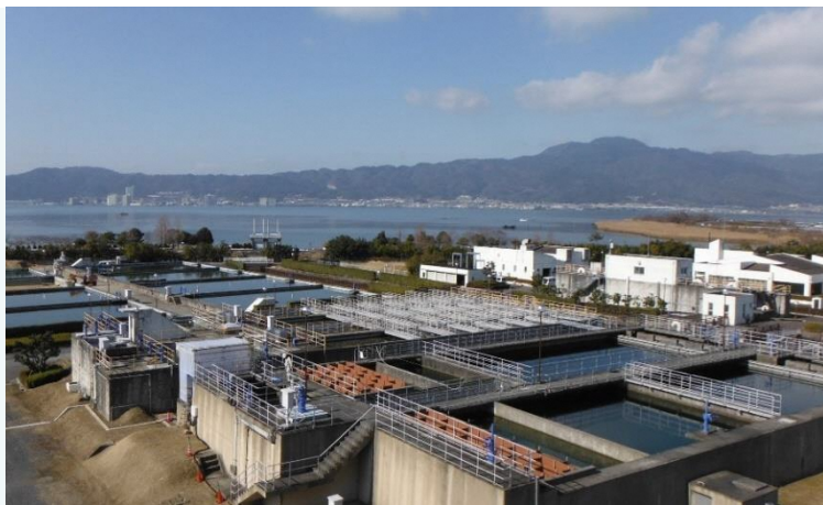
北山田浄水場
