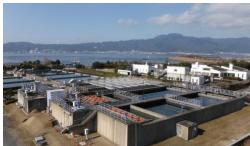
北山田浄水場
