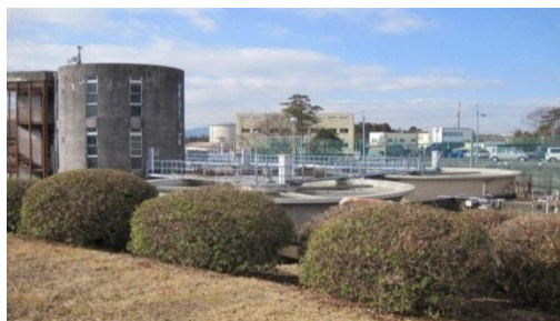
ロクハ浄水場旧館
