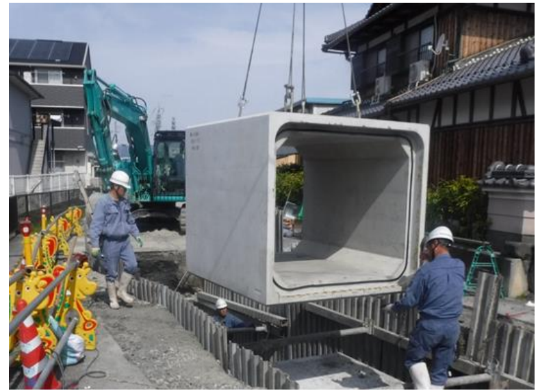
雨水管渠埋設状況
