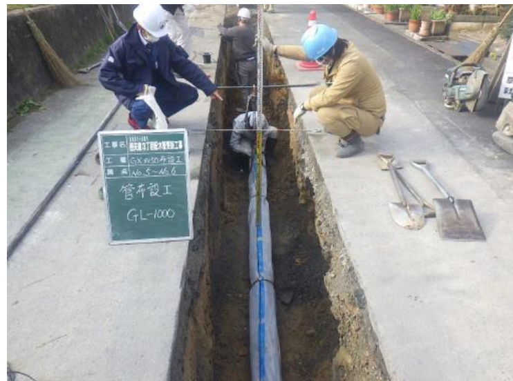
管路更新工事の様子
