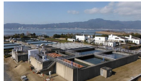
北山田浄水場
