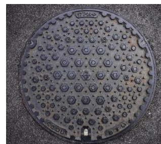
新規格マンホール蓋 (雨水浸入防止型)
