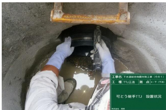
マンホールと下水道管の 接続部の耐震化施工状況
