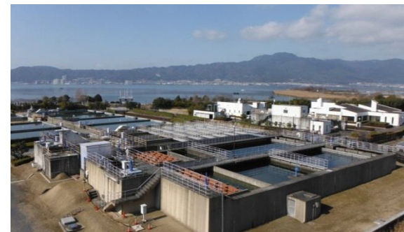
北山田浄水場
