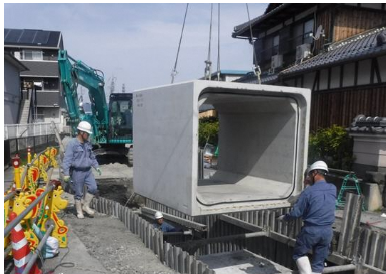
雨水管渠埋設状況
