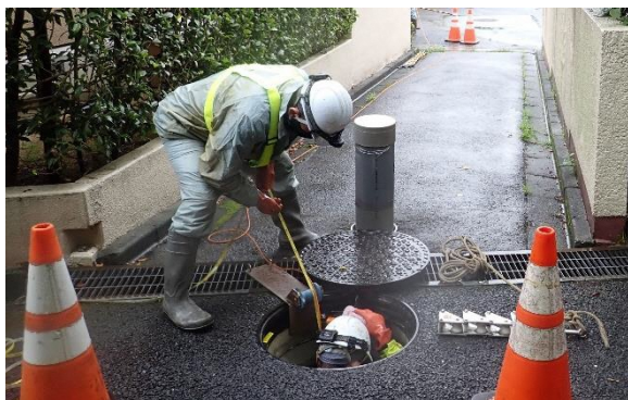
不明水調査状況
