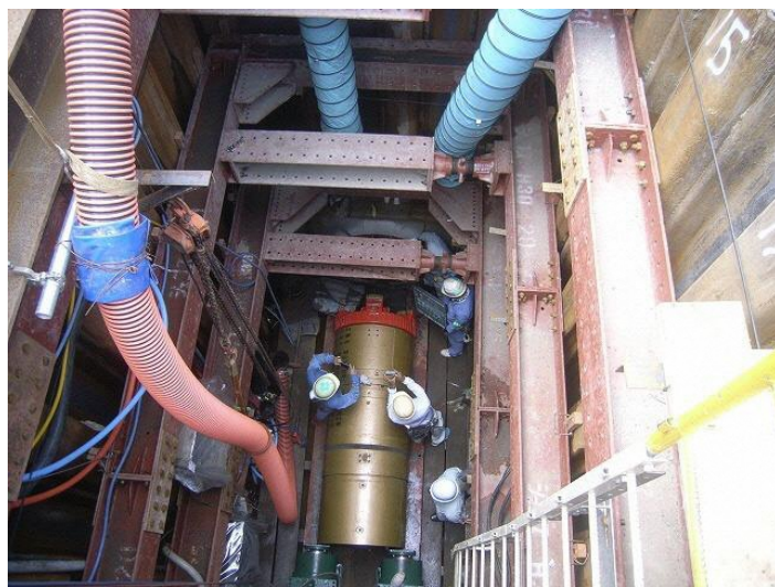
△汚水管の布設
