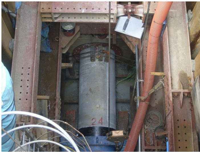
△汚水管の布設
