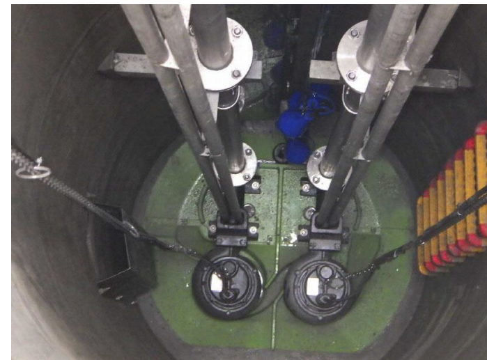
△マンホールポンプの新設
